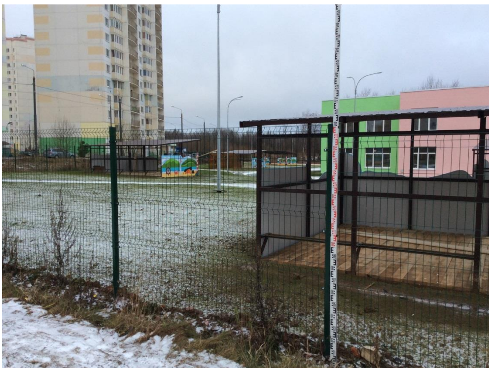
Рис. 13. Земельные участки с кадастровыми номерами 40:26:000374:1722, 40:26:000374:2332 для строительства объекта «Дошкольная образовательная организация на 325 мест», по адресу: г. Калуга, ул. Сиреневый бульвар». Видовая точка 4. Вид с востока.
