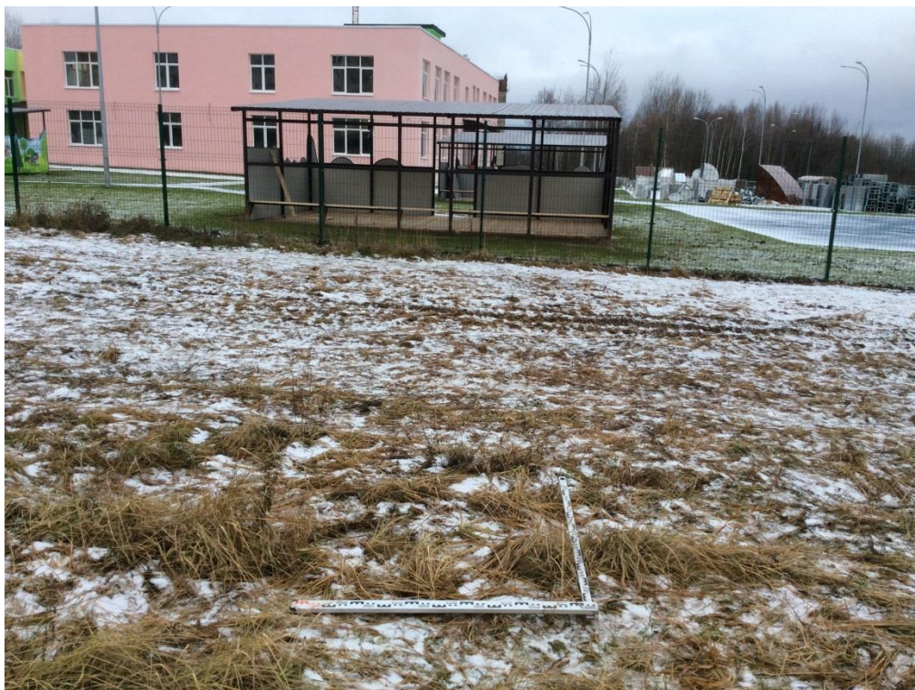
Рис. 17. Земельные участки с кадастровыми номерами 40:26:000374:1722, 40:26:000374:2332 для строительства объекта «Дошкольная образовательная организация на 325 мест», по адресу: г. Калуга, ул. Сиреневый бульвар». Место шурфа. Вид с востока.
