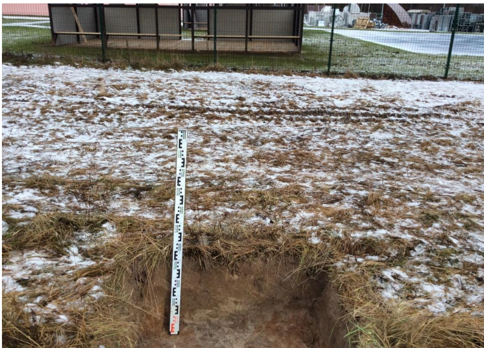
Рис. 19. Земельные участки с кадастровыми номерами 40:26:000374:1722, 40:26:000374:2332 для строительства объекта «Дошкольная образовательная организация на 325 мест», по адресу: г. Калуга, ул. Сиреневый бульвар». Шурф. Вид с востока.
